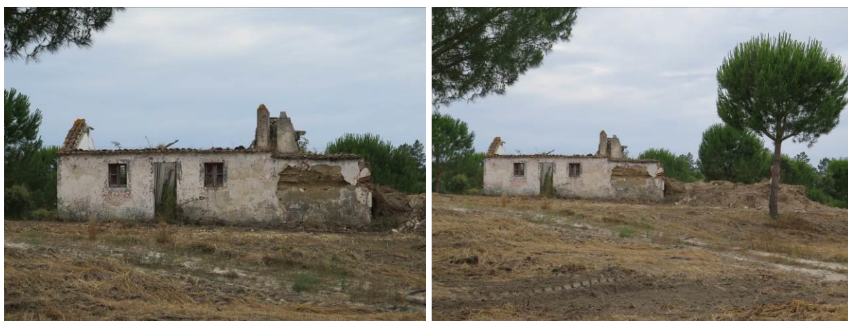
Fotografias 5.10 e 5.11 – Pequena casa agrícola em ruínas existente no perímetro da propriedade (38°20'21"N e 8°31'06"W).
